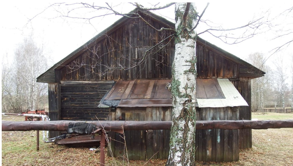
Рис. 2.3. Общий вид здания.
