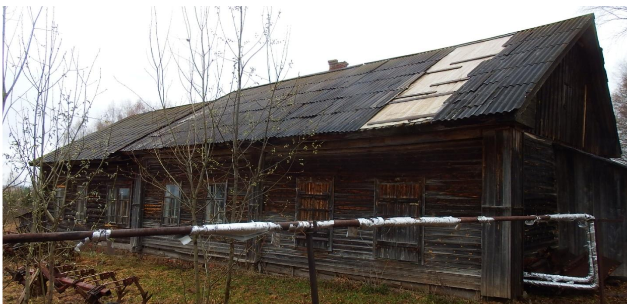
Рис. 2.4. Общий вид здания.
