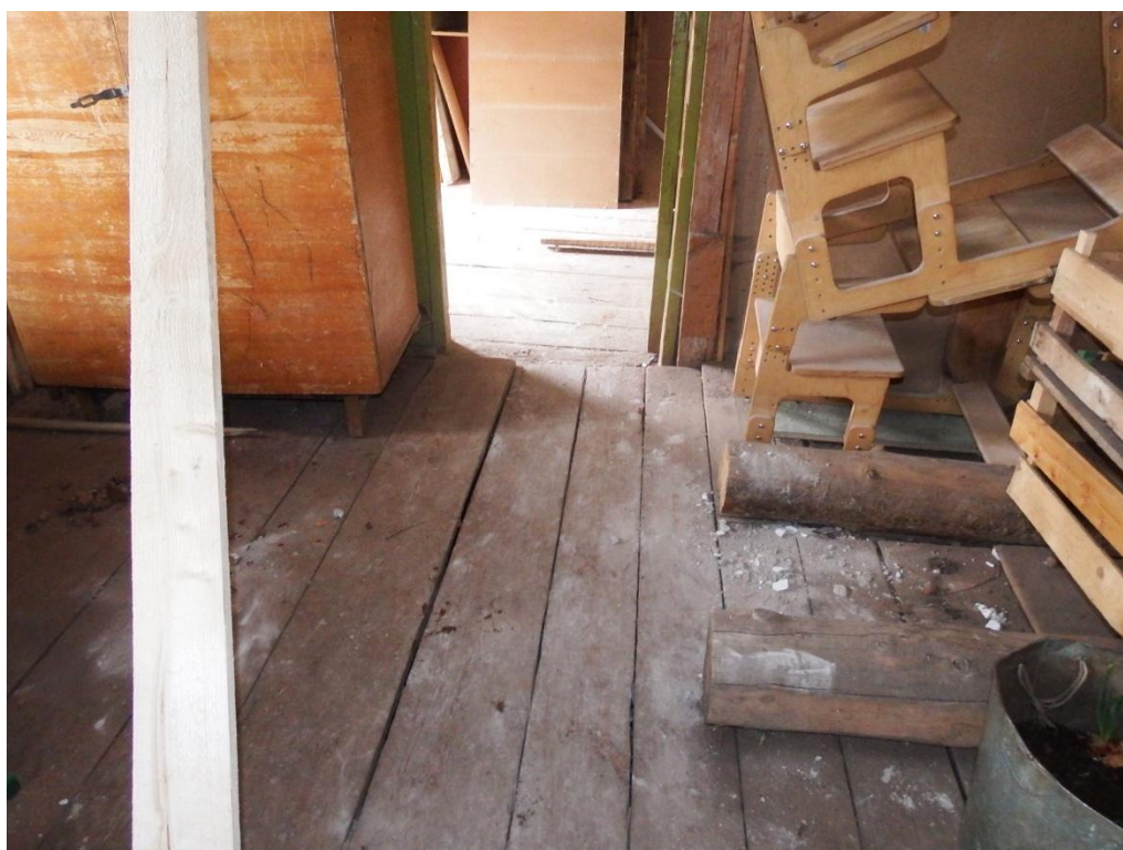
Рис. 2.8. Характерное состояние полов, рассыхание, щели и расстройство конструкции.
