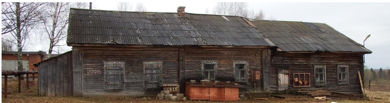
Рис. 2.2. Общий вид здания столярных мастерских.
